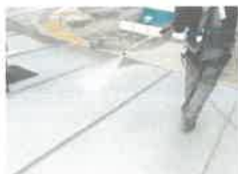
Przygotowanie podłoża za pomocą myjki ciśnieniowej
