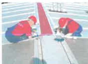
Uszczelnianie dachu przemysłowego
