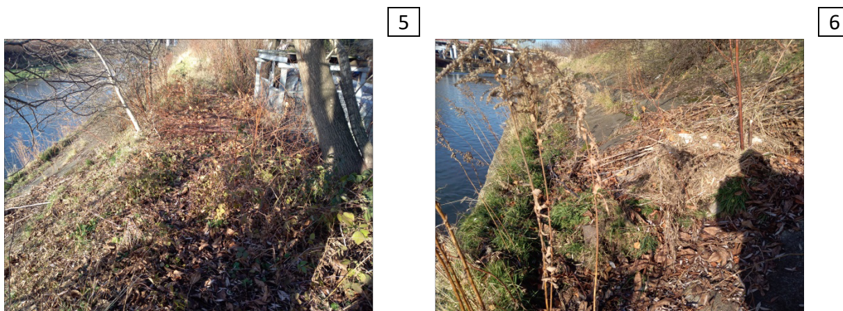
Rys. 1. Lokalizacja komory ciepłowniczej PS-30 i jej elementów: 1- komora ciepłownicza PS-30 wraz z magistralą ciepłowniczą 2xDN700 PÓŁNOC-2; 2 – wnętrze komory PS-30; 3 – widok na stalowy rurociąg DN200 upustowy i wąż do betonowej komory; 4 – wnętrze betonowej komory z widokiem dna oraz wlotu do stalowego rurociągu DN200; 5 – widok z korony nasypu ziemnego na komorę ciepłowniczą PS-30 oraz skarpe odwodną; 6 – lokalizacja istniejącego wylotu W-1 oraz stan techniczny skarpy odwodnej
